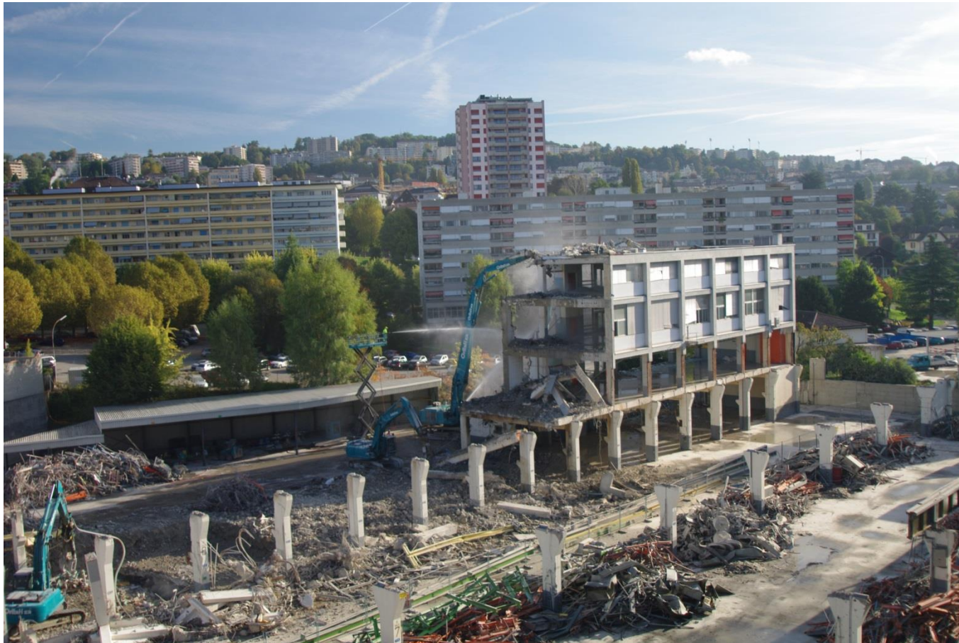
Déconstruction du site industriel Bobst à Prilly (2014)
